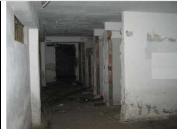
Figura 11: Particolare bagni piano seminterrato
