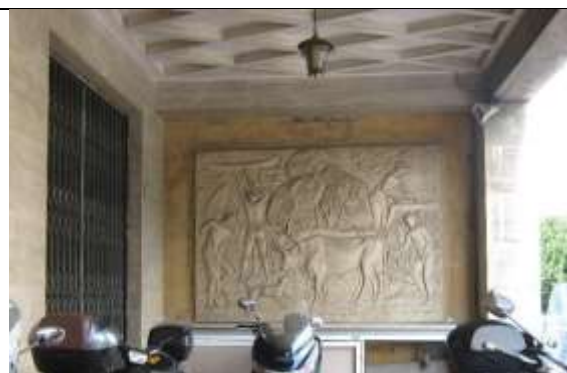
Figura 4: Particolare portico edificio vista Piazza della Libertà
