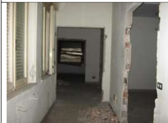
Figura 9: Particolare ingresso uffici piano primo
