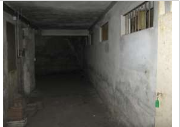
Figura 12: Particolare ripostiglio piano seminterrato
