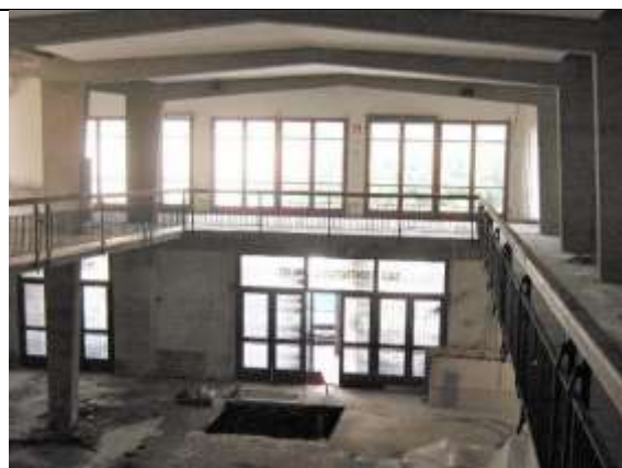
Figura 8: Particolare Sala Contrattazioni e piano primo
