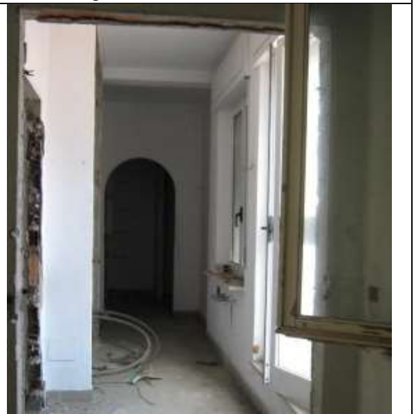
Figura 16: Particolare ingresso appartamento di servizio
