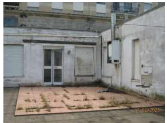
Figura 18: Particolare lastrico solare
