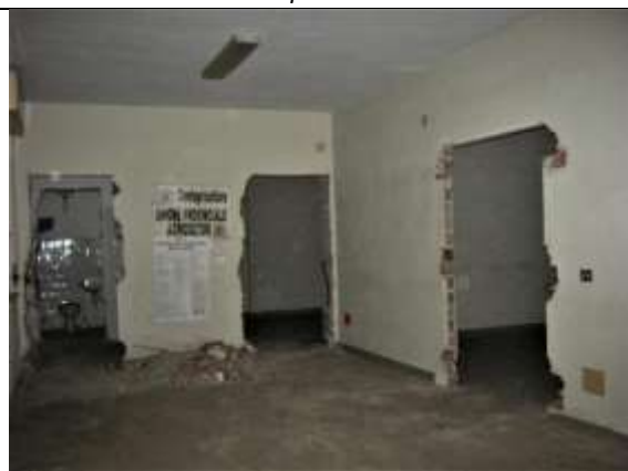
Figura 10: Particolare disimpegno uffici piano primo
