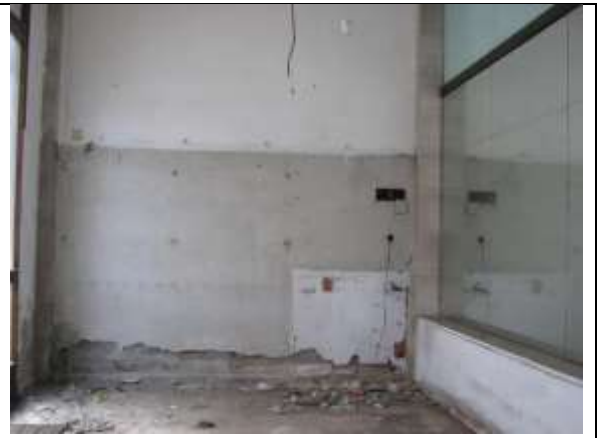
Figura 14: Particolare interno bar
