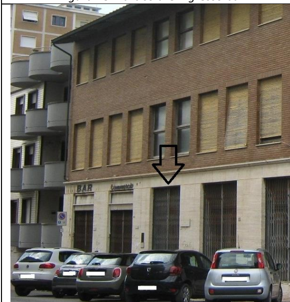
Figura 15: Particolare ingresso all'unità residenziale ed all'ufficio al piano secondo
