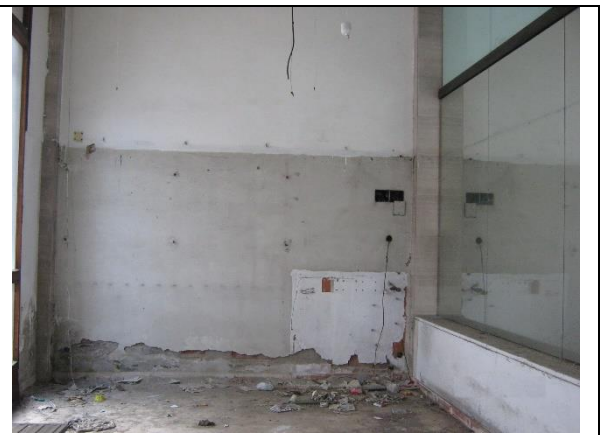
Figura 14: Particolare interno bar
