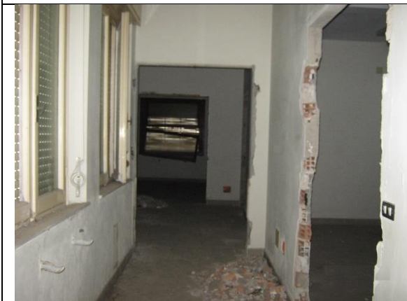
Figura 9: Particolare ingresso uffici piano primo
