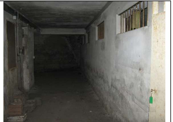
Figura 12: Particolare ripostiglio piano seminterrato
