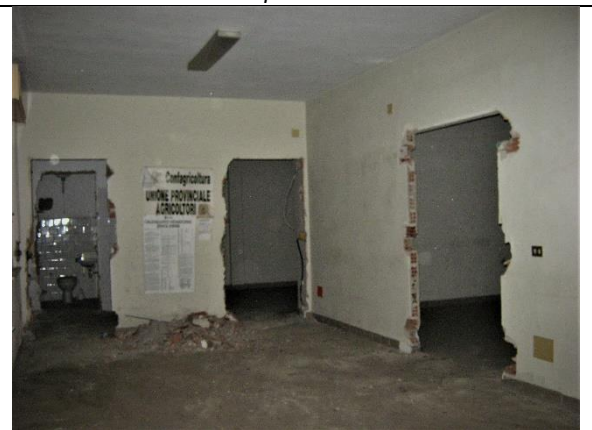
Figura 10: Particolare disimpegno uffici piano primo
