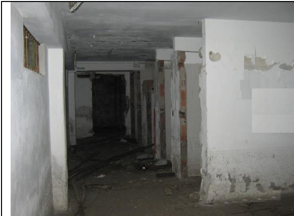
Figura 11: Particolare bagni piano seminterrato
