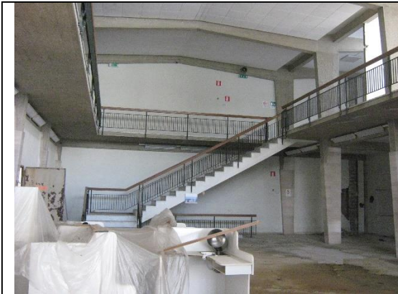
Figura 5: Particolare Sala Contrattazioni e scale accesso al piano seminterrato e primo
