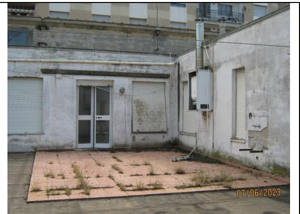
Figura 18: Particolare lastrico solare
