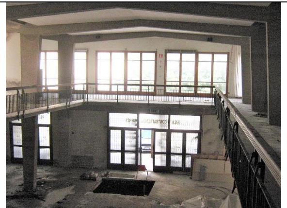
Figura 8: Particolare Sala Contrattazioni e piano primo
